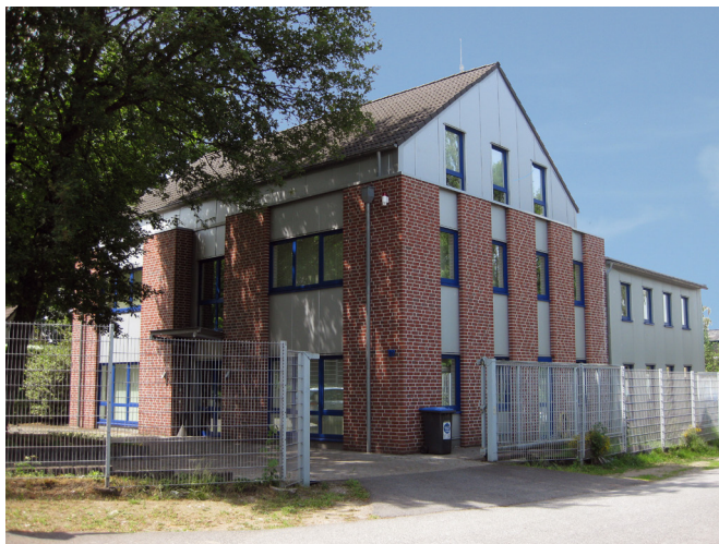
►► Das Firmengebäude der Dr. Bülow & Masiak GmbH in Marl.
